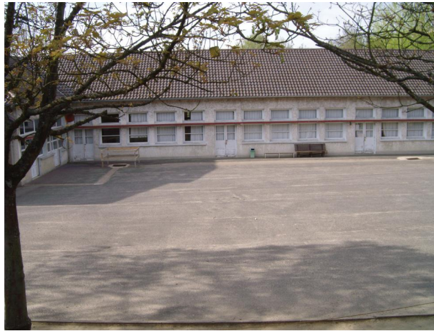
Le groupe scolaire intercommunal (Pontpoint-Rhuis-Roberval), rue des Ecoles, équipement majeur de la commune, réalisé en 1971.
