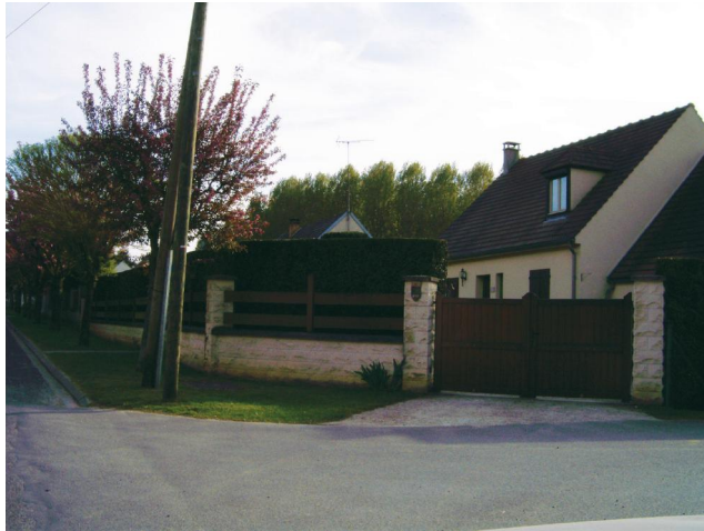
Clôture désormais classique des secteurs pavillonnaires, rue de l'Eglise. Un muret bas est surmonté de lisses en bois, complétées d'une haie de conifères taillés.
