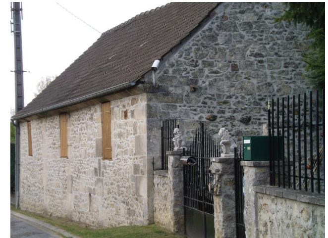
Mur de clôture ancien dans le prolongement de la construction, route de Guidon. Les portails ont été changés. Les percements ont sans doute également été modifiés.
