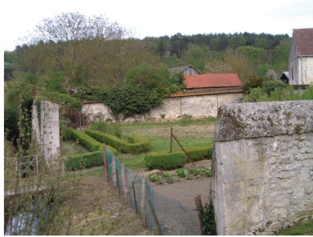
Les murs du clos lié au château sont bien entretenus. Ils témoignent d'un très ancien découpage de l'espace. Longeant l'eau, le mur central sépare la partie du jardin plus proche de la ferme. Son couronnement est varié : en tuiles au fond et en maçonnerie au premier plan.
