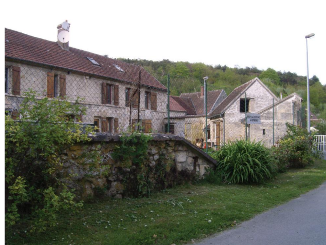
Maison ancienne en R+1+combles, chemin de Fosse. Sur la droite, on remarque également un appentis en R et une petite grange en R+C.
