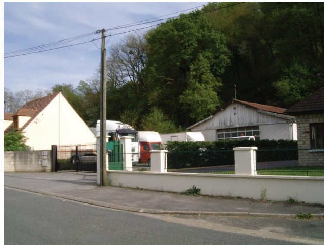
Ici, on remarque un bâtiment d'activité en rez-de-chaussée. Sa fonction de garage est marquée par une très grande porte centrée dans le pignon.
