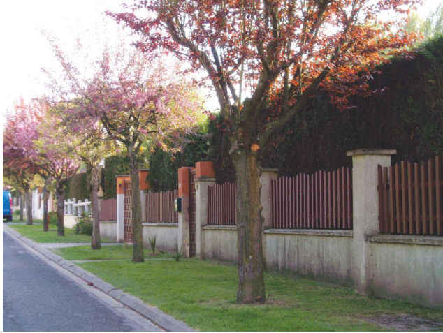
Rue de l'Eglise, clôture en parpaings avec un barreaudage en bois et une haie de thuyas pour ces pavillons construits dans les années 1980/1990.
