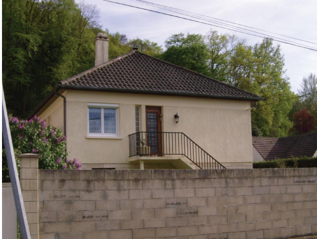
Maison des années soixante, à deux niveaux (R+1). Le garage se trouve en rez-de-chaussée et l'accès à l'habitation se fait directement au premier étage par un escalier extérieur.
