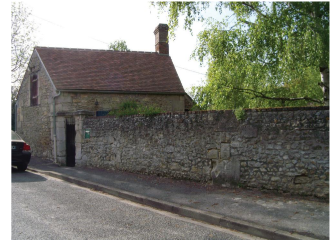
Ce mur de clôture, en continuité avec le bâtiment, est en bon état de conservation. On remarque au centre un chaînage qui marque soit la fin d'une période de construction, soit l'existence d'un angle, soit qui permettait d'augmenter la solidité du mur.
