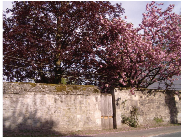
Le mur du château, réenduit sur cette section proche des bâtiments.
