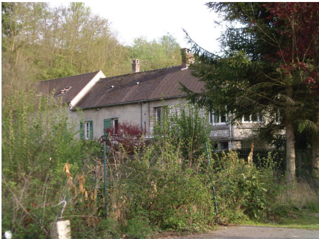
Ancienne construction dont l'extrémité à été restaurée, sans doute dans les années soixante, avec création de larges baies et de pans coupés.
