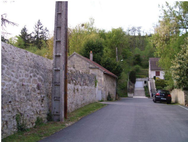
Murs anciens en continuité des bâtiments, cavée Martine. On lit ici clairement la limite de propriété : la rue est cadrée.
