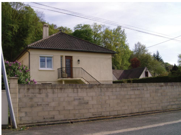
Construction réalisée dans les années 1960. Son toit à 4 pans en tuiles mécaniques, son volume assez cubique et son accès direct au premier étage sont caractéristiques.
