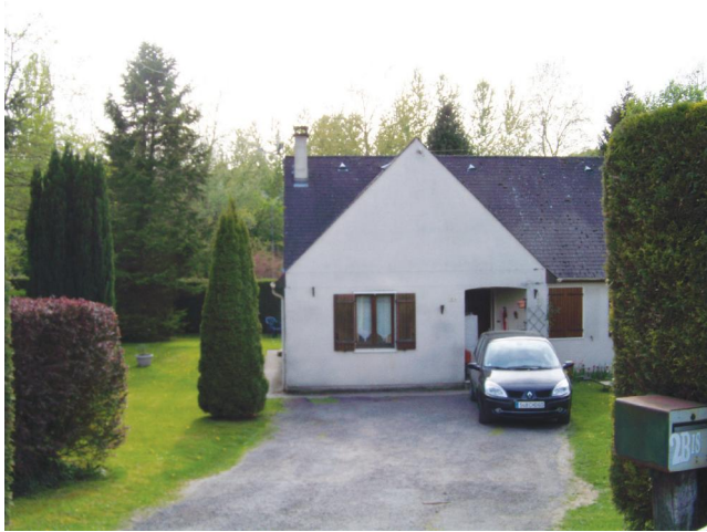
Cette maison récente, à Carrieuse, est typique des constructions pavillonnaires contemporaines : implantée en retrait, à distance des limites séparatives, avec un stationnement prévu entre la maison et la rue. Construite en L, elle offre un pignon un peu dénudé au premier regard.
