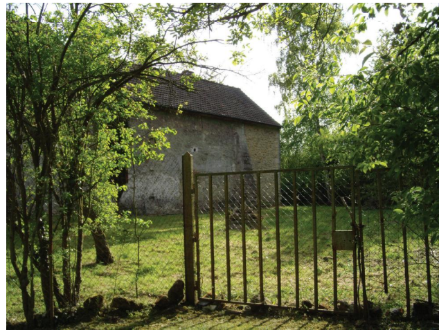
Bâtiment ancien appartenant à un corps de ferme, Cavée du Roi. Très simple, il devait s'agir d'une grange.
