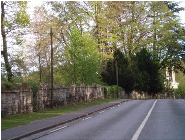
Très long mur d'enceinte du château, le long de la route de Guidon. Selon les sections, il présente des couronnements différents, avec des effets de style : maçonné en arrondi, plat... (voir ci-dessous)
