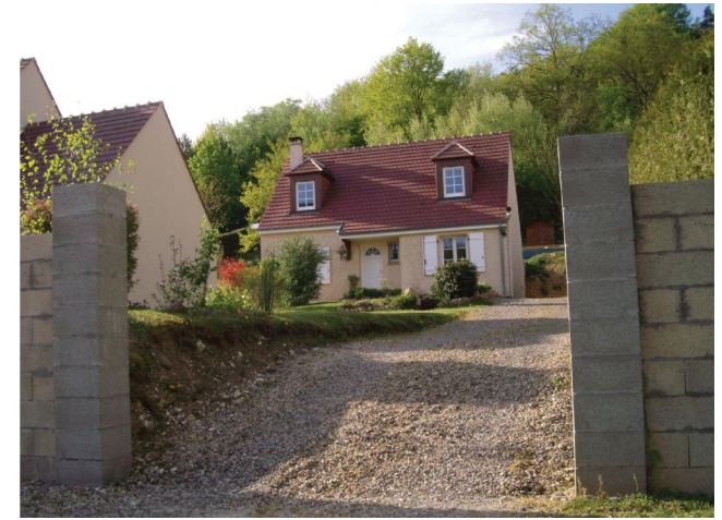
Pavillon récent : on retrouve des lucarnes à croupe. La porte s'installe dans un espace en retrait, ce qui est par contre une habitude plutôt contemporaine.
