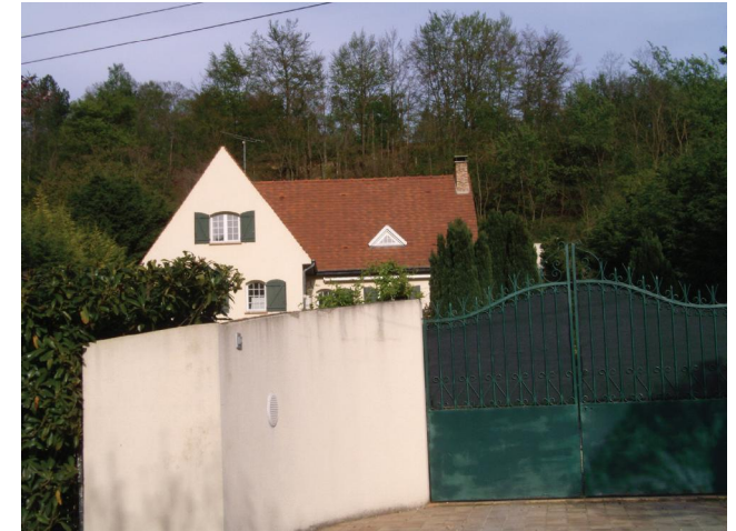
La haie végétale formant clôture se termine autour du portail sur un mur en béton enduit. Pas de pilastres pour le portail qui s'accroche directement au mur.
