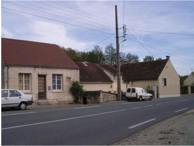
Habitation ancienne route de Guidon. La toiture vient d'être refaite en tuiles plates mécaniques, ce qui lui donne un aspect «rigide» par rapport à celles réalisées en tuiles plates traditionnelles.
