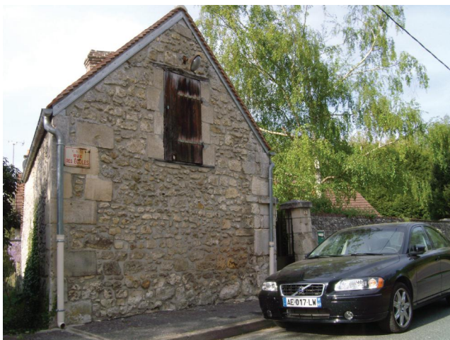
Ancienne grande ou apprentis aujourd'hui transformé en habitation. L'ensemble est bien entretenu, la toiture a été rénovée dans l'esprit d'origine de la construction.
