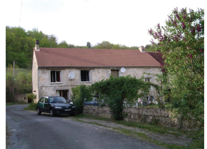
Construction ancienne à Fosse, en R+1. La toiture vient d'être refaite mais les combles n'ont pas été, pour autant, aménagés.
