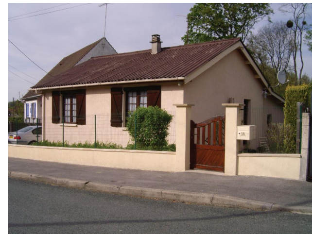
Construction réalisée probablement dans les années soixante, rue de l'Eglise. Cette maison de petite taille est couverte en fibrociment. Ce cas se retrouve sur quelques maisons voisines.
