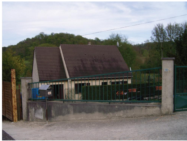
Ce pavillon, route de Guidon, présente un très grand volume de toiture non aménagé. Les pentes créées sont ainsi très différentes de celles du bâti traditionnel.
