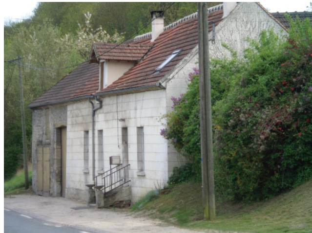
La grange initiale de cet ensemble route de Guidon a été étendu, probablement au début du XXe siècle, par une maison d'habitation en pierres de taille calcaires. On retrouve, en toiture, la traditionnelle lucarne jacobine.
