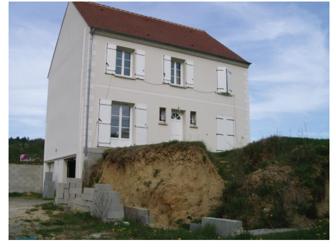
Cette construction toute récente chemin de Carrieuse présente un travail de modénature rappelant les constructions plus anciennes. Cependant, sa position en hauteur (décaissement de la partie gauche du terrain) nécessitera un traitement soigné de ses abords pour éviter cette présence massive. La porte reste néanmoins sous dimensionnée, comme c'est fréquemment le cas de ce type de constructions.
