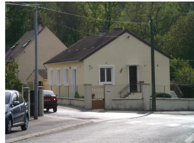
Exemple de construction des années soixante récemment rénovée, Cavée du Roi. On accède directement au premier étage par un escalier extérieur.
