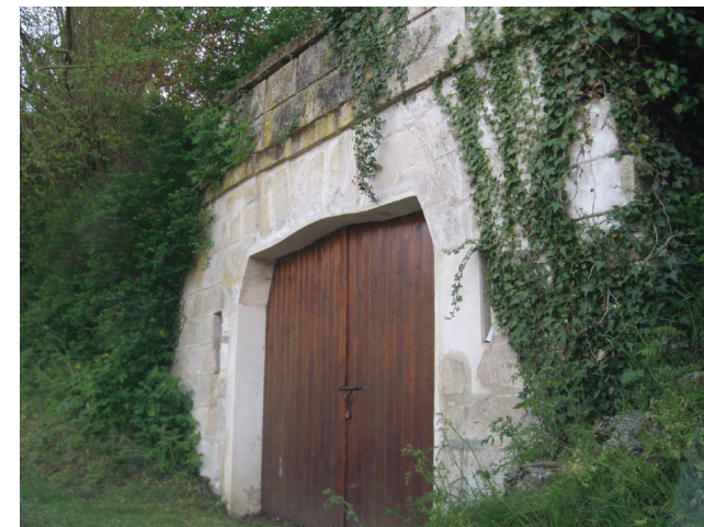
Installée dans une différence de niveau de terrain, chemin de Carrireuse, cette ancienne cave est toujours en usage : sa porte a été refaite.
