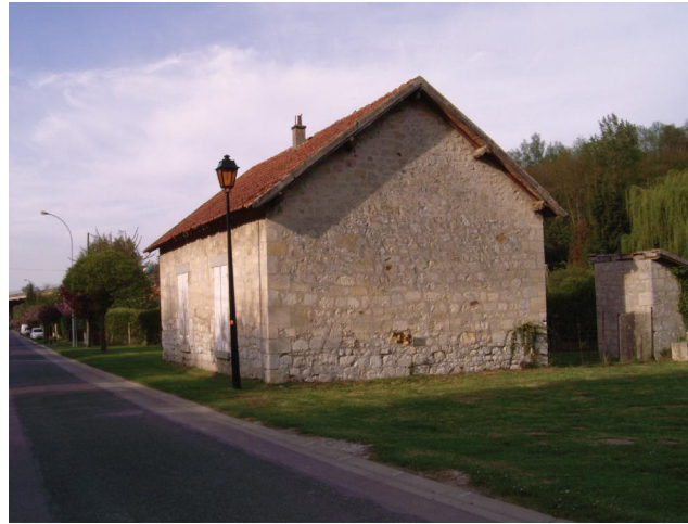
Maison ancienne à un seul niveau, rue de l'Eglise.
