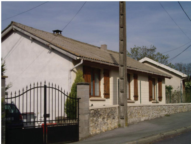
Maison en rez-de-chaussée, rue des Ecoles. Relativement basse, elle est couverte en fibrociment gris.
