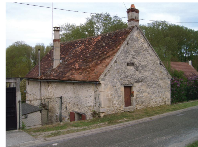
Maison d'habitation ancienne (qui fut probablement une grange) installée en contre-bas de la route de Guidon. Une ouverture dans le pignon permet l'accès au niveau supérieur alors que l'accès principal se trouve au niveau inférieur.
