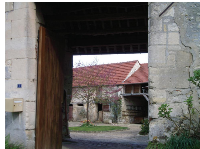
Dans cette cour intérieure de l'ancienne ferme, chemin de Carriuse, on remarque un bâtiment porche en bois reliant deux bâtiments en pierre. On retrouve cette configuration dans l'ancien prieuré de Noël-Saint-Rémy.
