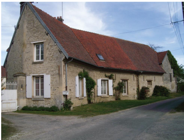
La ferme liée au château, chemin de Carrieuse, a été reconverte en habitat. On peut supposer qu'elle a été redivisée en différentes propriétés, comme semblent en témoigner les différences de matériaux de toiture et l'absence de volets sur la partie la plus éloignée du bâtiment.
