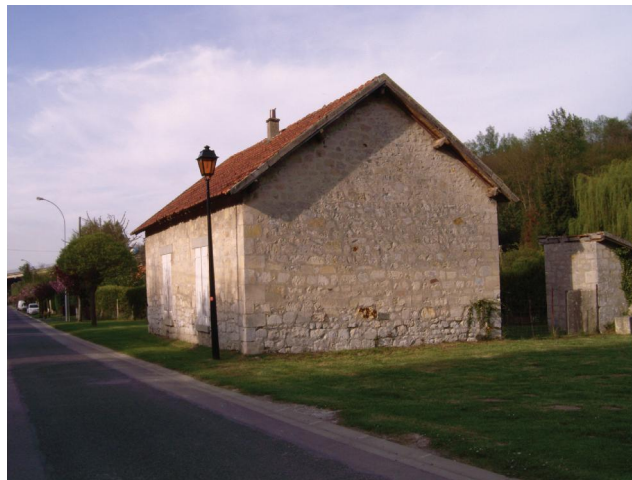
Maison ancienne en rez-de-chaussée, rue de l'Eglise. Son volume est simple.
