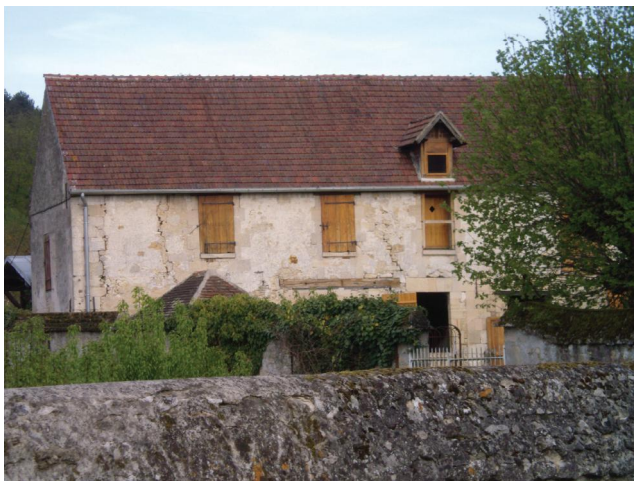
La ferme liée au château derrière le mur de clôture : la toiture du bâtiment a été refaite mais la lucarne jacobine a été conservée. On retrouve ce type de lucarnes assez fréquemment à Roberval.
