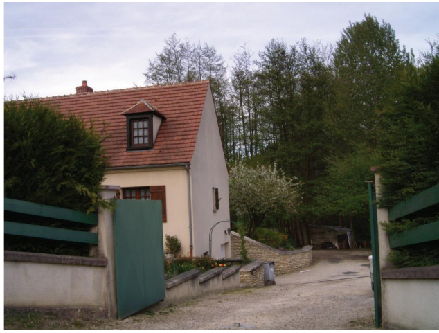
Construction individuelle en retrait de la route de Guidon. Des lucarnes à la capucine ont été créées rappelant les traditionnelles lucarnes dite «jacobines». Un rampe permet l'accès à la maison et au garage en rez-de-chaussée de la maison.
