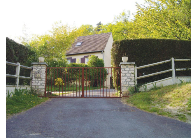
Clôture contemporaine, relativement hétérogène, chemin de Fosse : chaque élément de la clôture relève d'un vocabulaire différent : piliers en fausse maçonnerie, clôture en béton, portail métallique simplement barreaudé.
