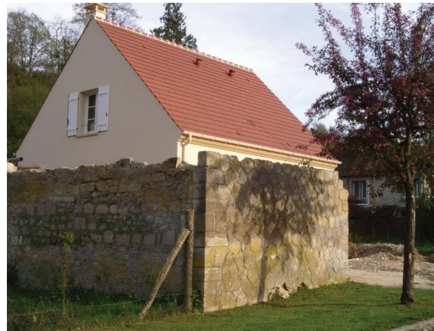
L'ancien mur d'une construction précédente a été conservé devant cette nouvelle construction. Encore en bon état, il servira de base pour la nouvelle clôture.
