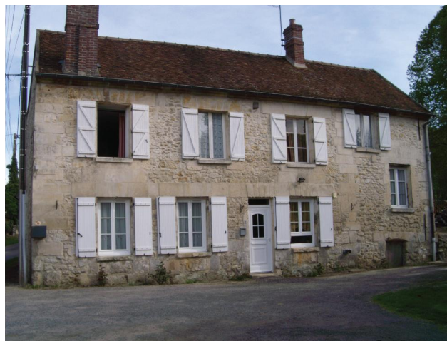
Cette construction ancienne à deux niveaux a été, comme beaucoup d'autres, modifiée : on remarque à droite de la construction un décalage des fenêtres et la trace de la chaîne d'angle qui marquait la limite de la construction initiale.
