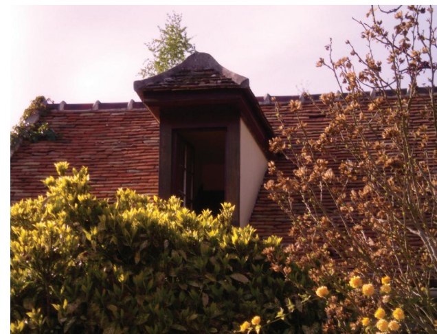
Ancienne lucarne à croupe (dite aussi à capucine). Des détails architecturaux de qualité à noter et préserver.
