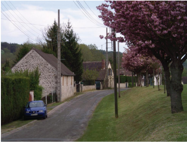
Enfilade d'habitations anciennes, route de Guidon. Elles présentent de petit volumes sur rue car elles utilisent le dénivelé du terrain : elles présentent souvent un niveau de plus desservi en contre-bas.
