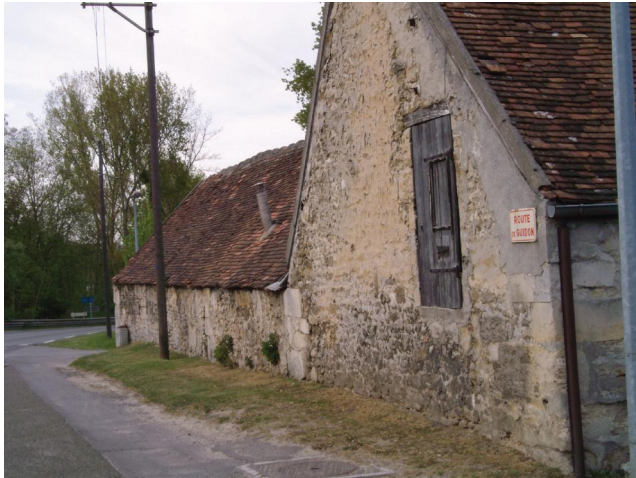
Ce bâtiment appartenant à une ancienne ferme, route de Guidon, est trompeur. En rez-de-chaussée côté rue, la construction peut atteindre deux niveaux côté cour.
