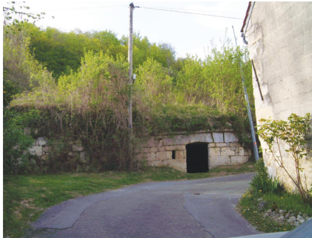
Ancienne cave, chemin de Fosse. Elle résulte d'un usage astucieux du dénivelé et de la nature du terrain. En effet, de nombreuses caves anciennes parsèment Roberval, et, en raison de la configuration du terrain (sous-sol humide, coteaux nombreux) elles se trouvent souvent situées à l'écart des maisons.
