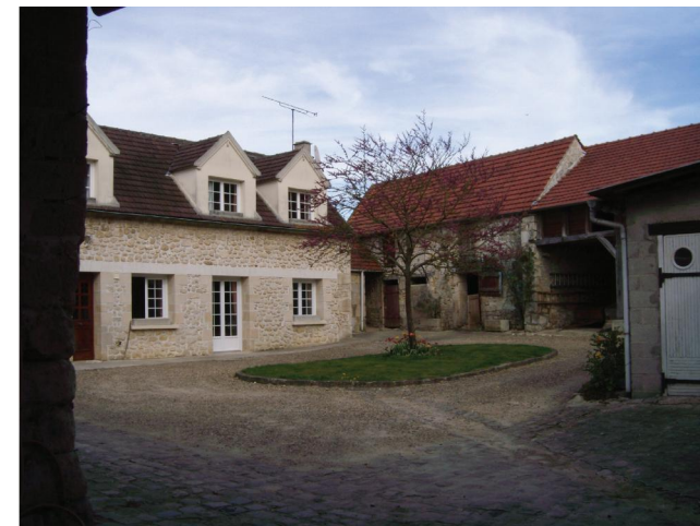
Cour intérieure de la ferme du chemin de Carriuses : les bâtiments ont aujourd'hui un usage d'habitation et ont donc été rénovés. On remarque sur la façade de la maison principale, que des lucarnes ont été créées ou agrandies, sans doute pour aménager les combles. Leurs proportions sont très importantes au regard du reste de la construction. Les percements ont également été refaits et les volets supprimés.
