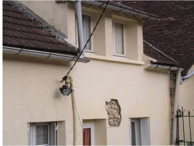
Exemple de maison ancienne, route de Guidon, transformée par une importante rénovation : elle a été surélevée et les murs ont été recouvert d'un enduit épais. On aperçoit au centre les pierres de construction d'origine.
