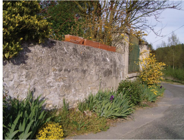
Mur enduit, à Fosse, avec des plantations soignées en pied de mur.
