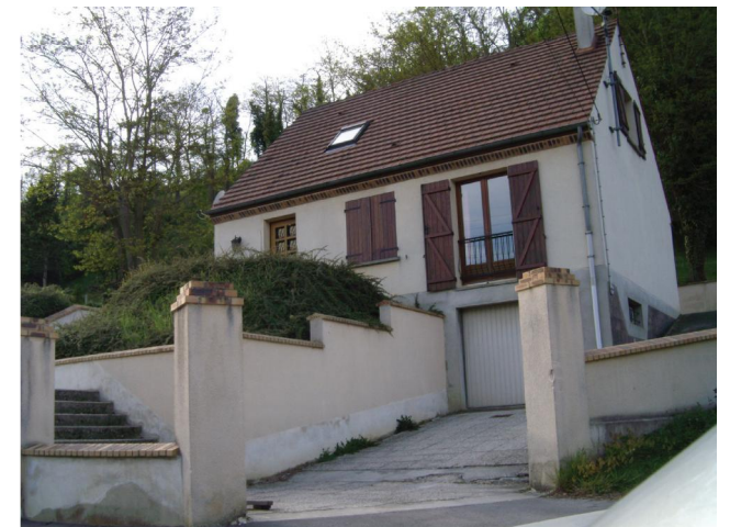
Construction des années quatre-vingt, chemin d'Harcelay. Le garage est installé dans la pente et semi-enterré. L'accès à l'habitation se fait par le niveau haut. Toute ces particularités la distingue des maisons de bourg anciennes qui l'entourent à Noël-Saint-Rémy.
