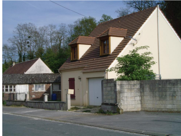
Construction récente en R+ combles, rue de l'Eglise. C'est le nombre de niveaux que l'on retrouve de la façon la plus fréquente pour les nouvelles constructions de type pavillonnaire.
